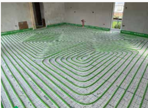
Heizungsrohre auf Klett verlegen
