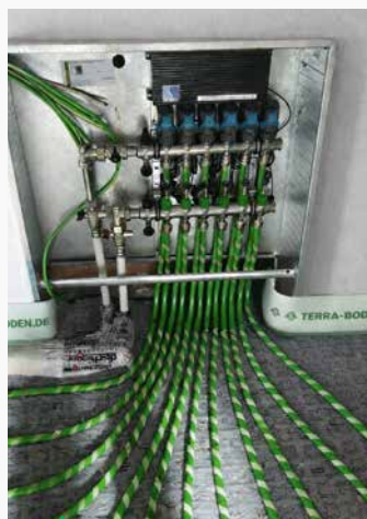
Heizungsrohre an Verteiler anschließen
